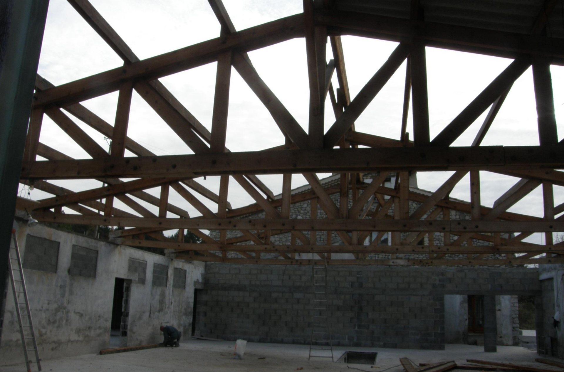
Travaux en cours dans le vieux hangar/bergerie pour aménager les salles d'expo.
